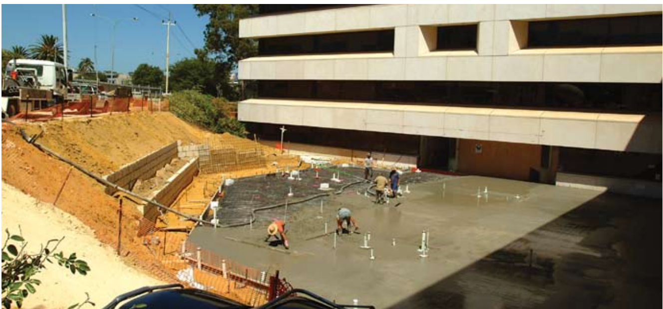
Concrete pour for the new Johanna Sewell Adolescent Oncology Unit
